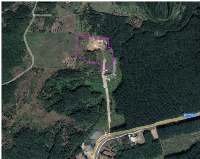
a, Phạm vi bãi rác Hưng Phước
