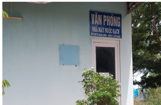
Nhà máy nước TT Tân Phú (DPD)
