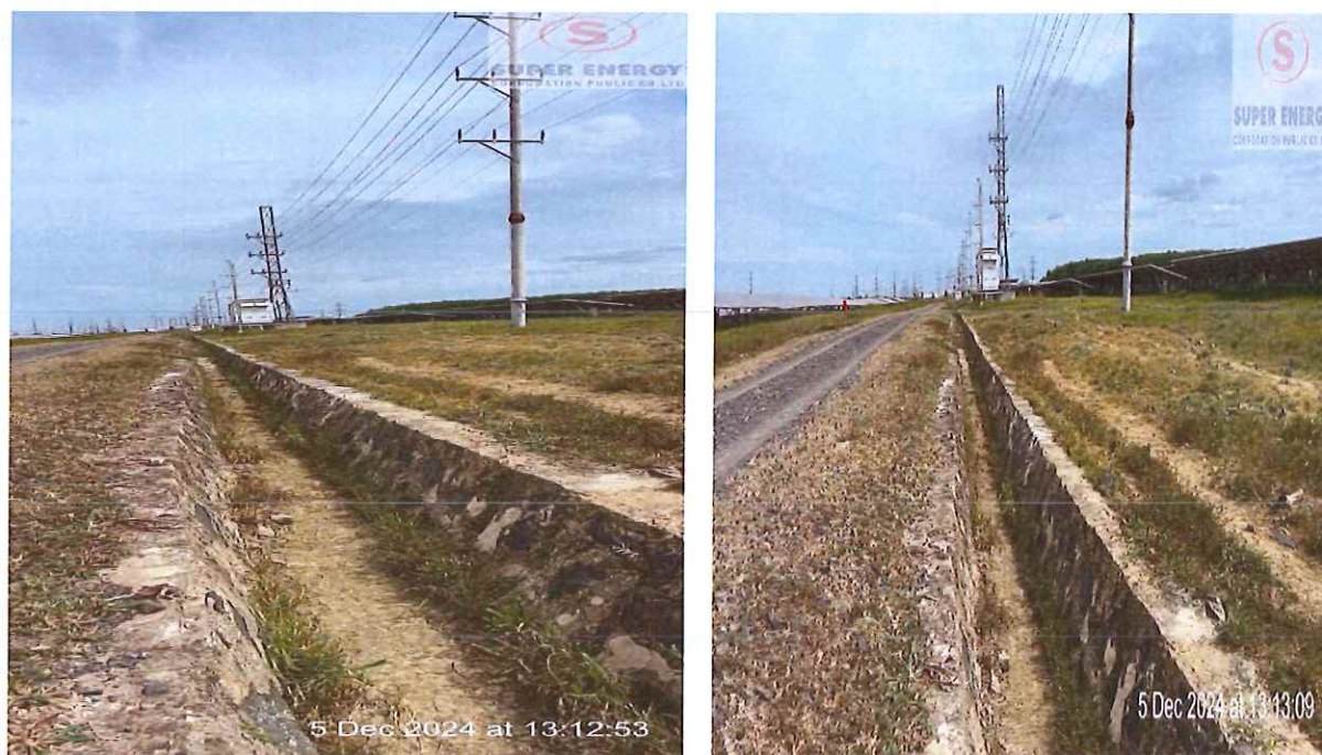
Hình 3.2. Rãnh thoát nước mưa của nhà máy
