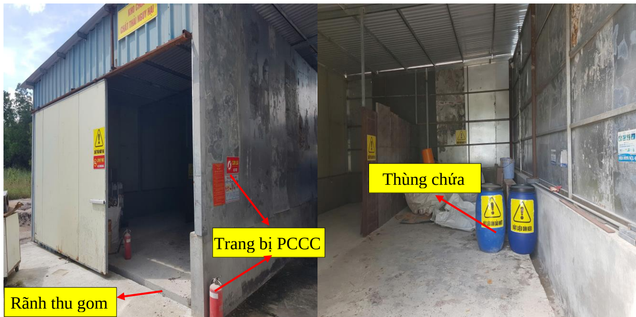
Hình 4.24. Hình ảnh kho CTNH và rãnh thu gom chất thải tràn đổ tại kho CTNH
