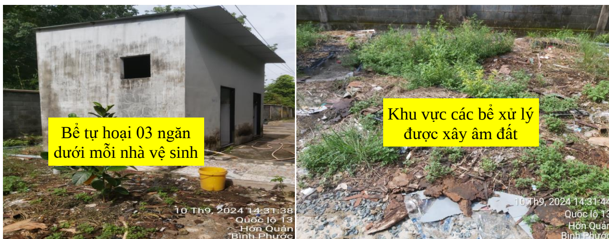
Hình 4.18. Khu vực nhà vệ sinh và cụm bể xử lý tại Nhà máy
