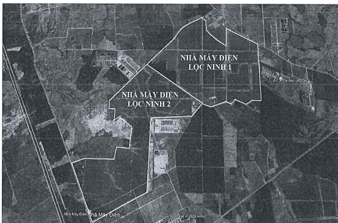
Hình 1.1. Vị trí nhà máy điện Lộc Ninh 1
