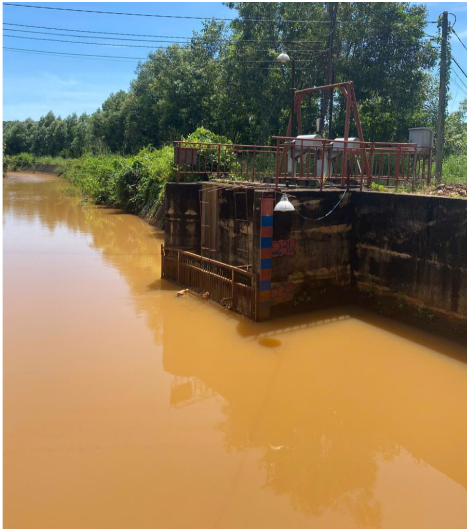
Cửa dẫn nước từ kênh dẫn xuống tua bin phát điện
