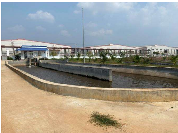
Bể vi sinh G.SBR 1st
