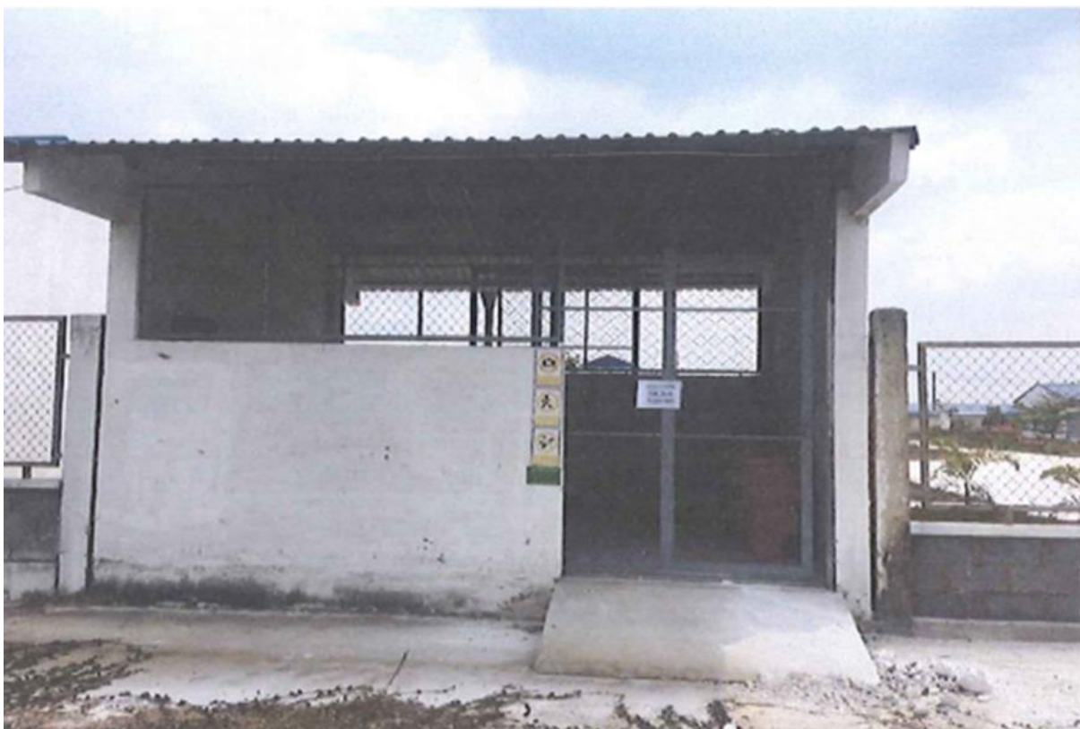
Hình 3.6. Nhà kho chứa rác thải sinh hoạt
