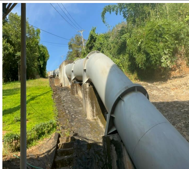
Tuyến ống áp lực bằng thép đi nổi
