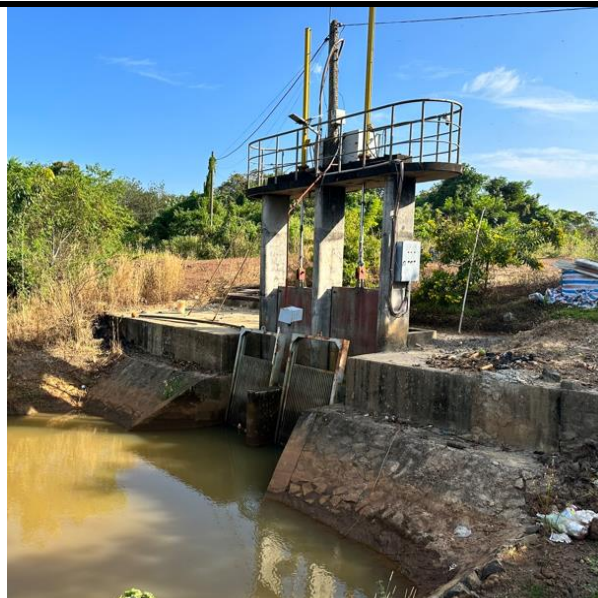
Cửa lấy nước đầu tuyến ống áp lực chìm
