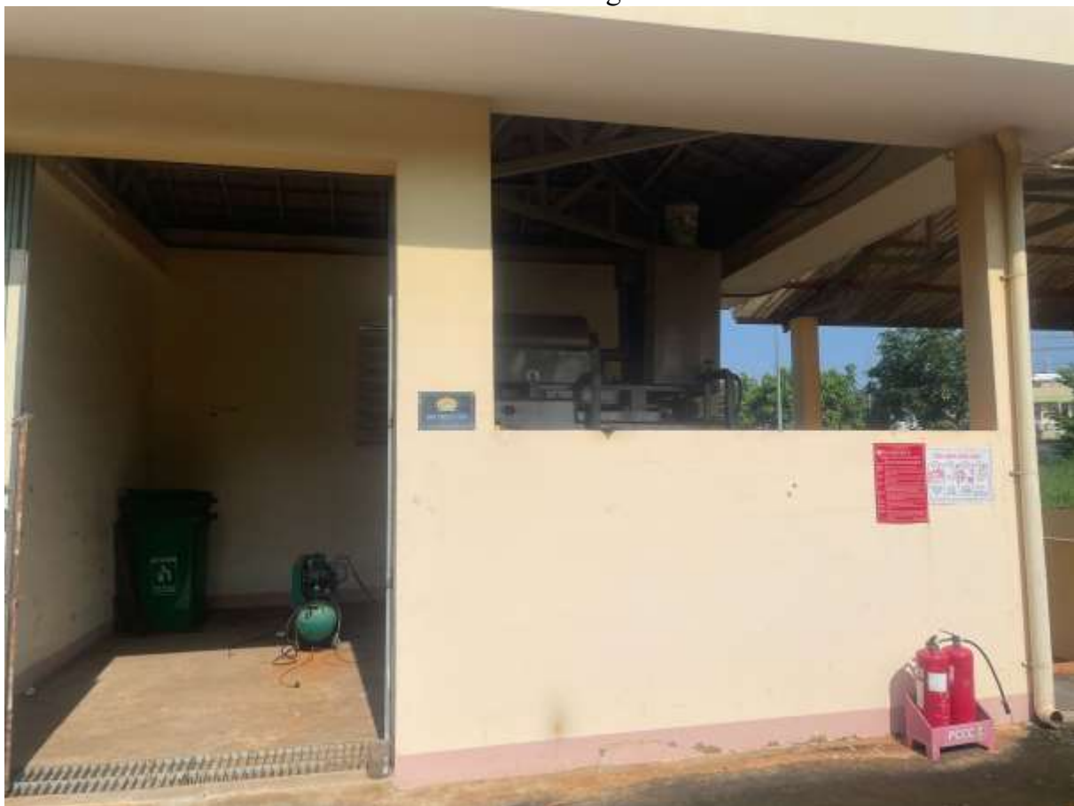
Nhà chứa ép bùn
