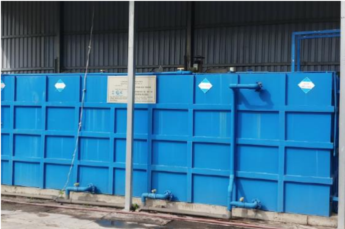
Hình 3.4: Hình ảnh minh họa hệ thống XLNT sinh hoạt bằng hộp khối
