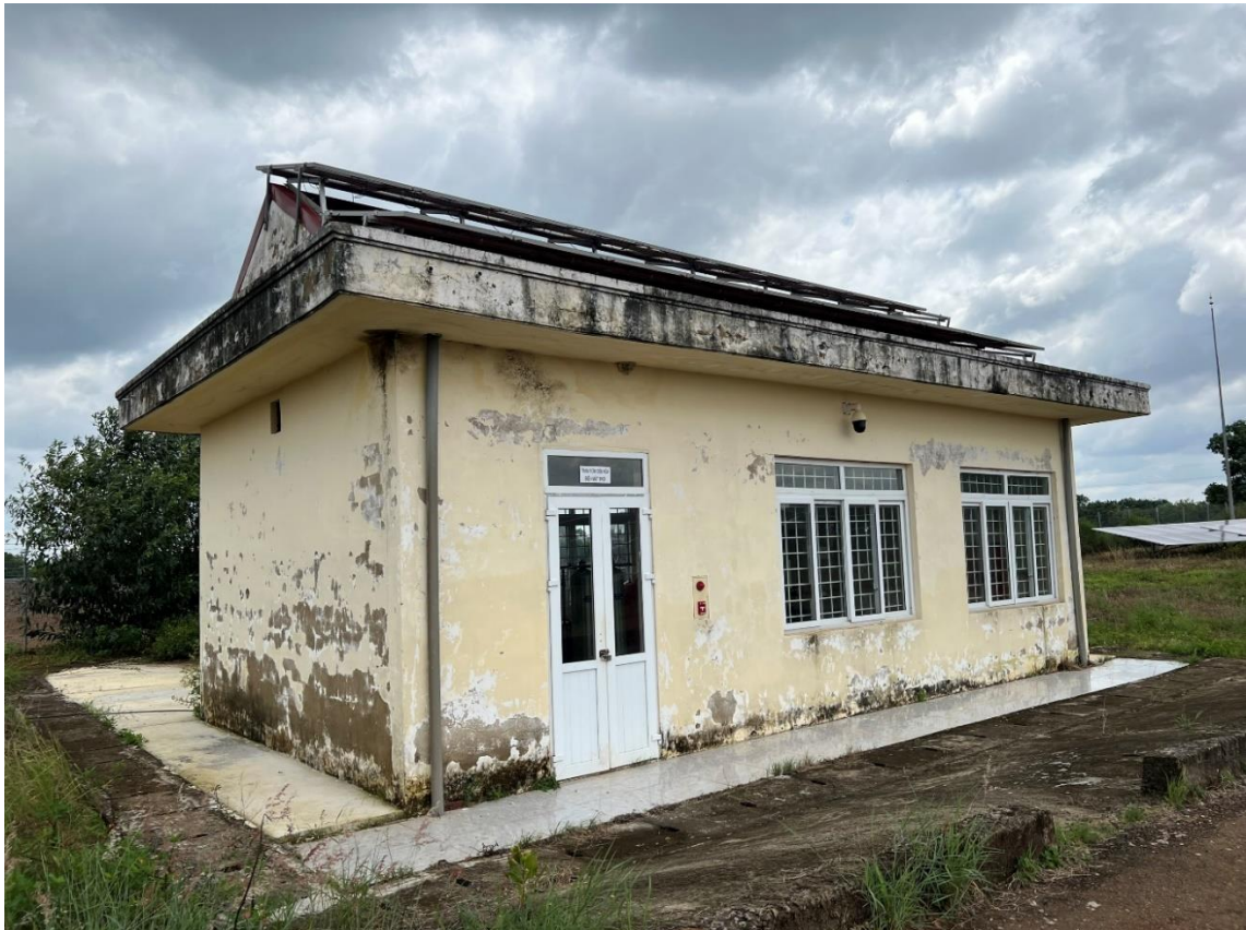
Hình 3.6: Trạm bơm cứu hỏa tại nhà máy điện mặt trời Thác Mơ
