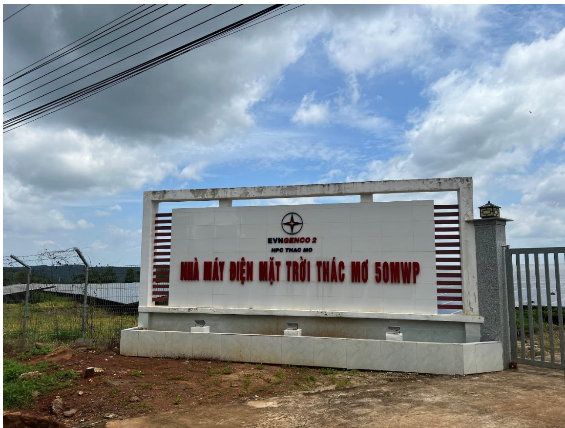
Hình 1.2: Cổng nhà máy điện mặt trời Thác Mơ
