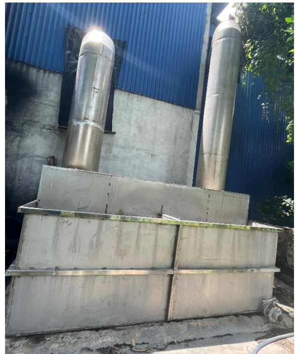
Hình 3. 6 Hệ thống xử lý khí thải lò dầu tản nhiệt (ống khói cao 18m)
