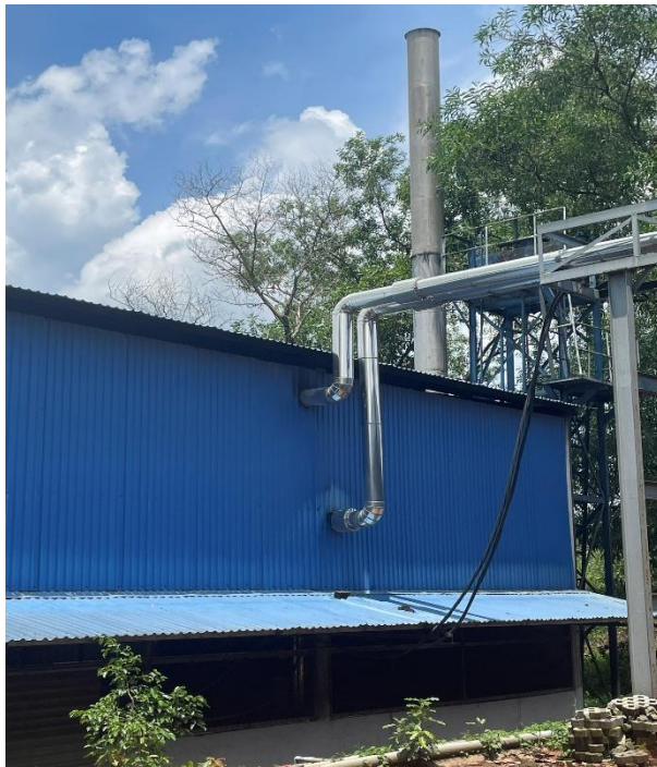
Hình 3. 6 Hệ thống xử lý khí thải lò dầu tản nhiệt (ống khói cao 18m)
