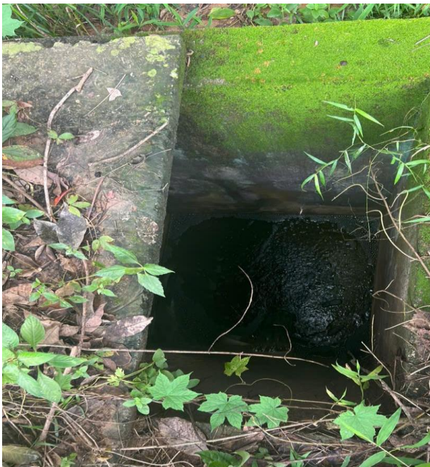
Hố ga nước thải sau xử lý và nguồn tiếp nhận (suối Cầu Hai)
