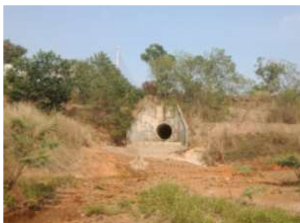
Cống thoát nước mưa từ KĐT Cát Tường Phú Hưng chảy qua dự án
