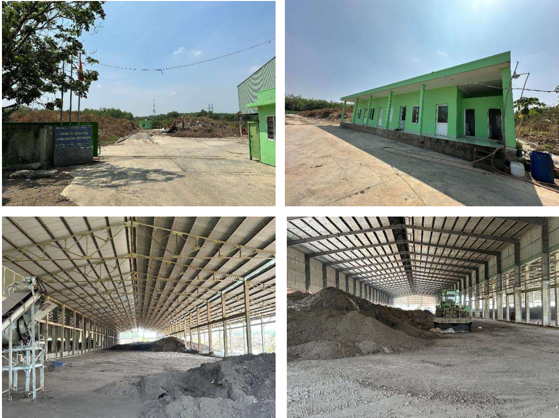
Hình 1.2. Hiện trạng Cơ sở
