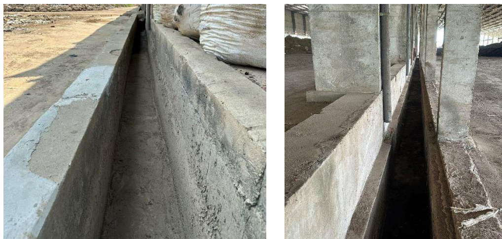
Hình 3.2. Mương hở thu gom nước mưa khu vực xưởng sản xuất
