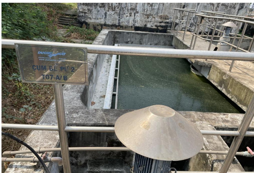
CỤM BỂ PHẢN ỨNG 2
