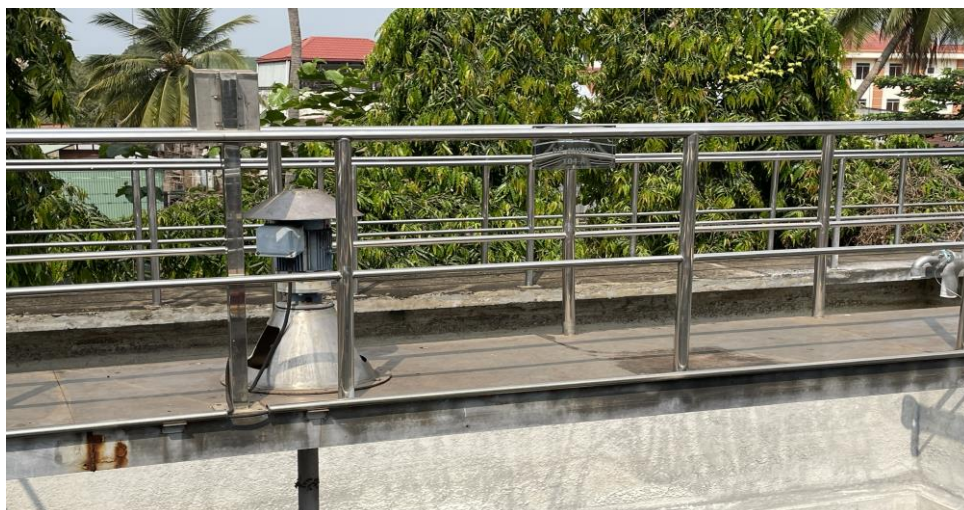
CỤM BỂ PHẢN ỨNG 1
