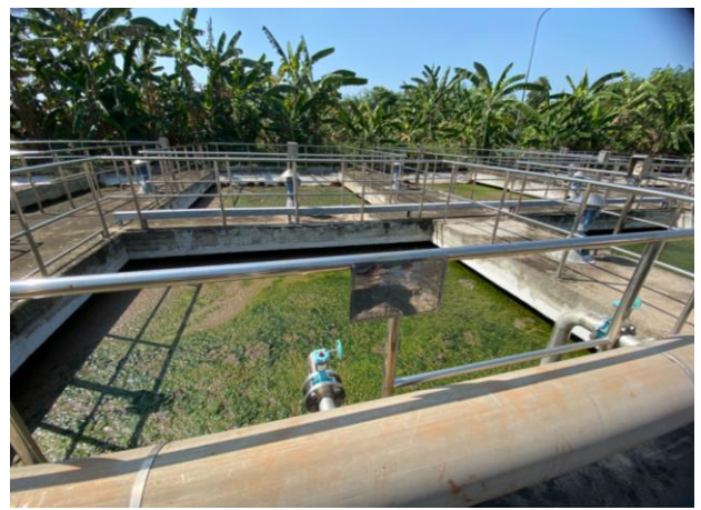
Bể Anoxic T09-B
