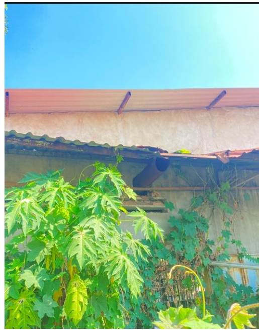
Hình 3. 12: Ống thoát khí thải máy phát điện 591 KVA (bên trái) và 837 KVA (bên phải)
