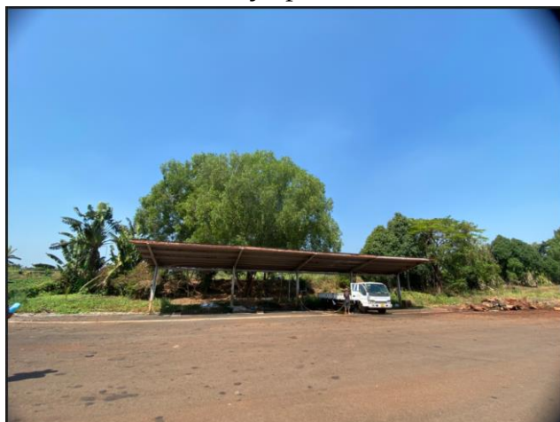
Khu vực rửa xe chở mù và hố thu nước rửa xe ngầm phía dưới
