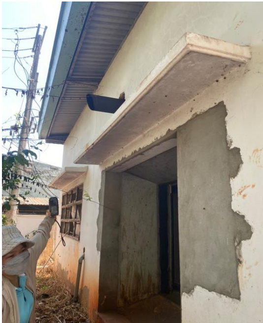
Hình 3. 12: Ống thoát khí thải máy phát điện 591 KVA (bên trái) và 837 KVA (bên phải)
