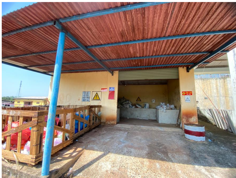
Hình 3.16: Hình ảnh thực tế khu vực tập kết CTR sinh hoạt có mái che bố trí phía ngoài kho chứa CTNH
