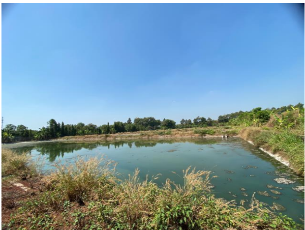
Bể ổn định (3 bể)
