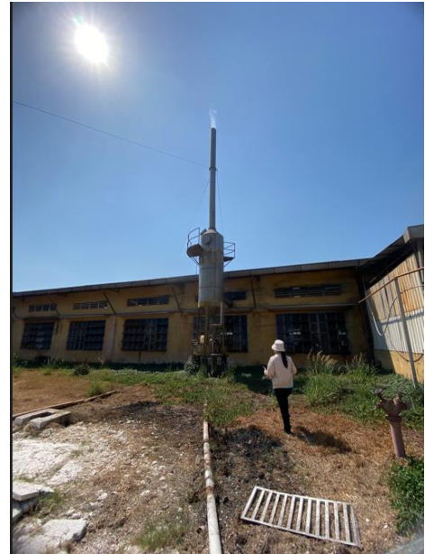
Hình 3. 13: Ống thoát hơi lò sấy mũ cốm từ mũ nước(hình trái); tháp khử mùi và ống thoát hơi mũ cốm từ mũ tạp (hình phải)
