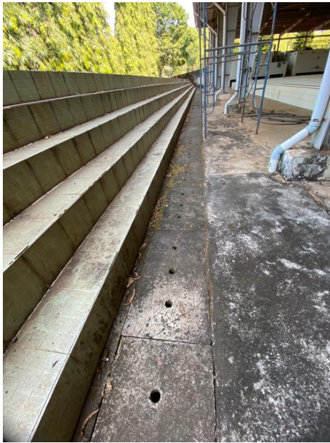
Hình 3. 2: Mương thoát nước mưa tại dự án
