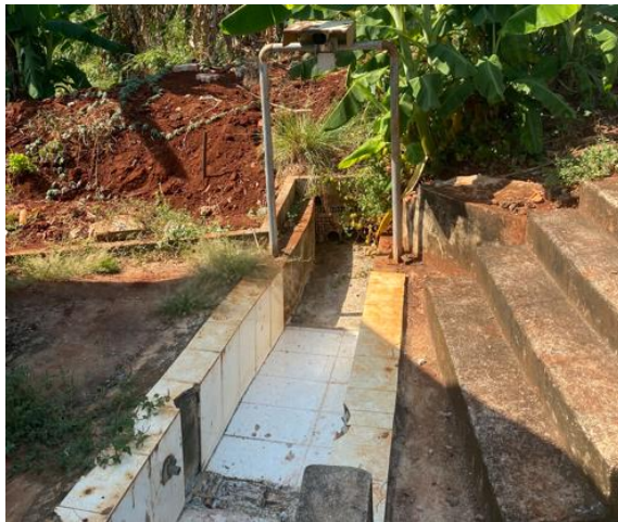
Hình 3. 6: Đường mương dẫn nước sau xử lý
