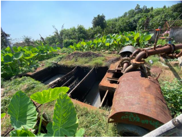
Hố thu (nước thải từ xưởng chế biến mủ côm từ mủ tạp)
