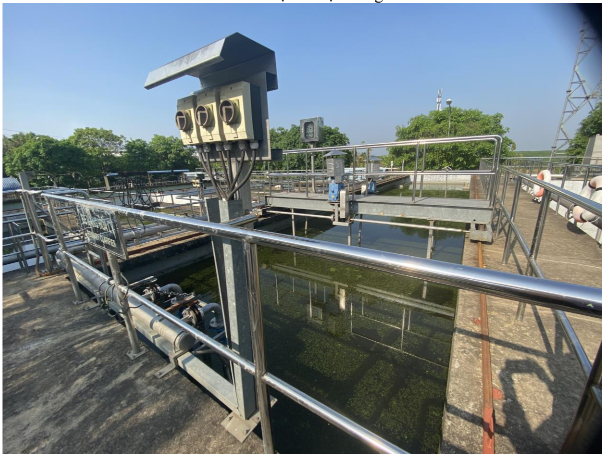
Bể lắng sơ cấp
