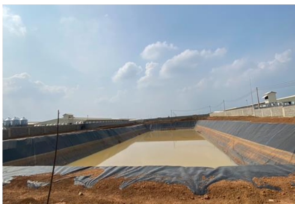
Hình 3. 6: Hồ chứa nước thải sau xử lý kích thước 100x35x5m (bên trái) và 70x35x5m (bên phải)
