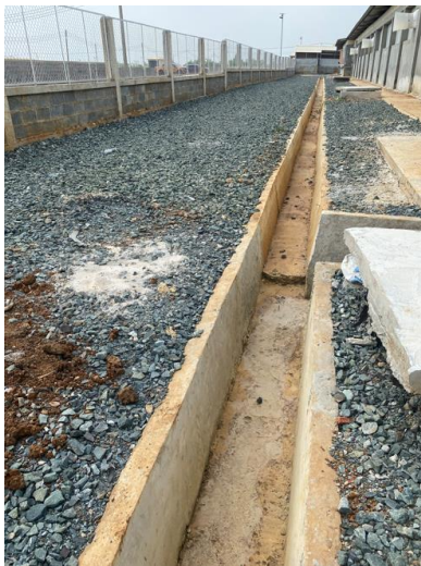
Hình 3. 2: Cổng thu gom nước mưa
