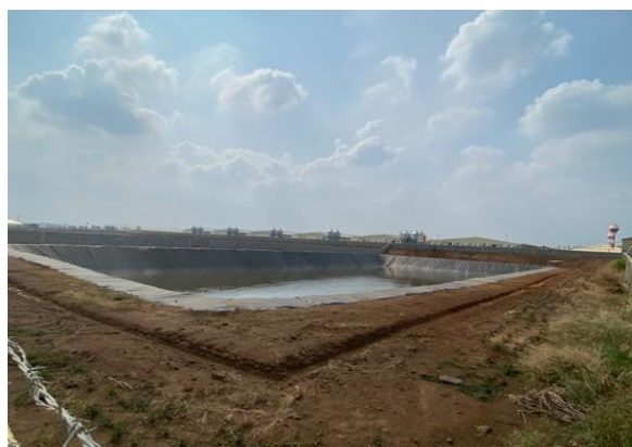
Hình 3. 6: Hồ chứa nước thải sau xử lý kích thước 100x35x5m (bên trái) và 70x35x5m (bên phải)
