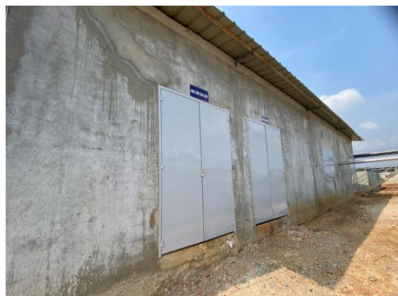
Khu vực nhà chứa hóa chất, nhà điều hành
