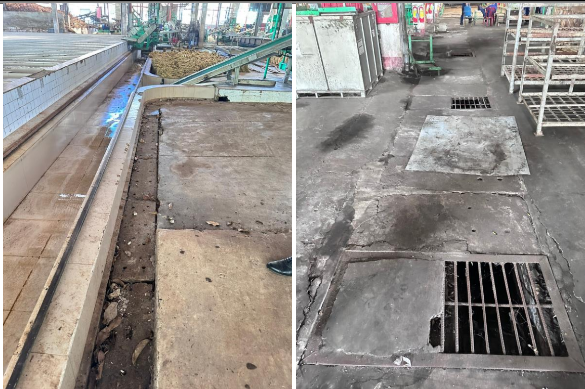
Hình 3. 6: Hình ảnh thực tế mương và hố ga thoát nước thải mủ tạp
