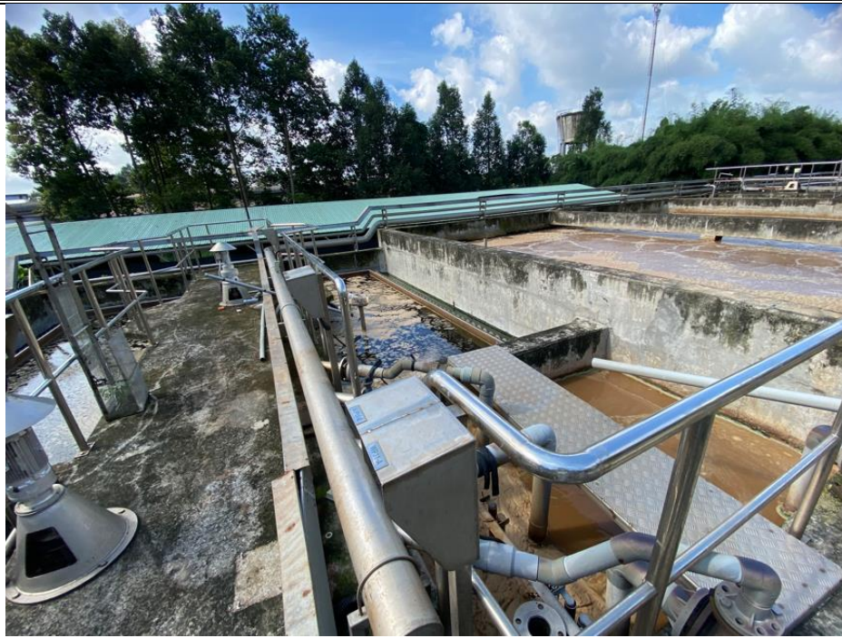
Hình 22: Bể lắng 12A
