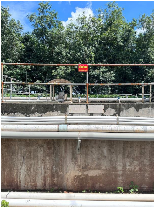
Hình 5: Bể hiếu khí
