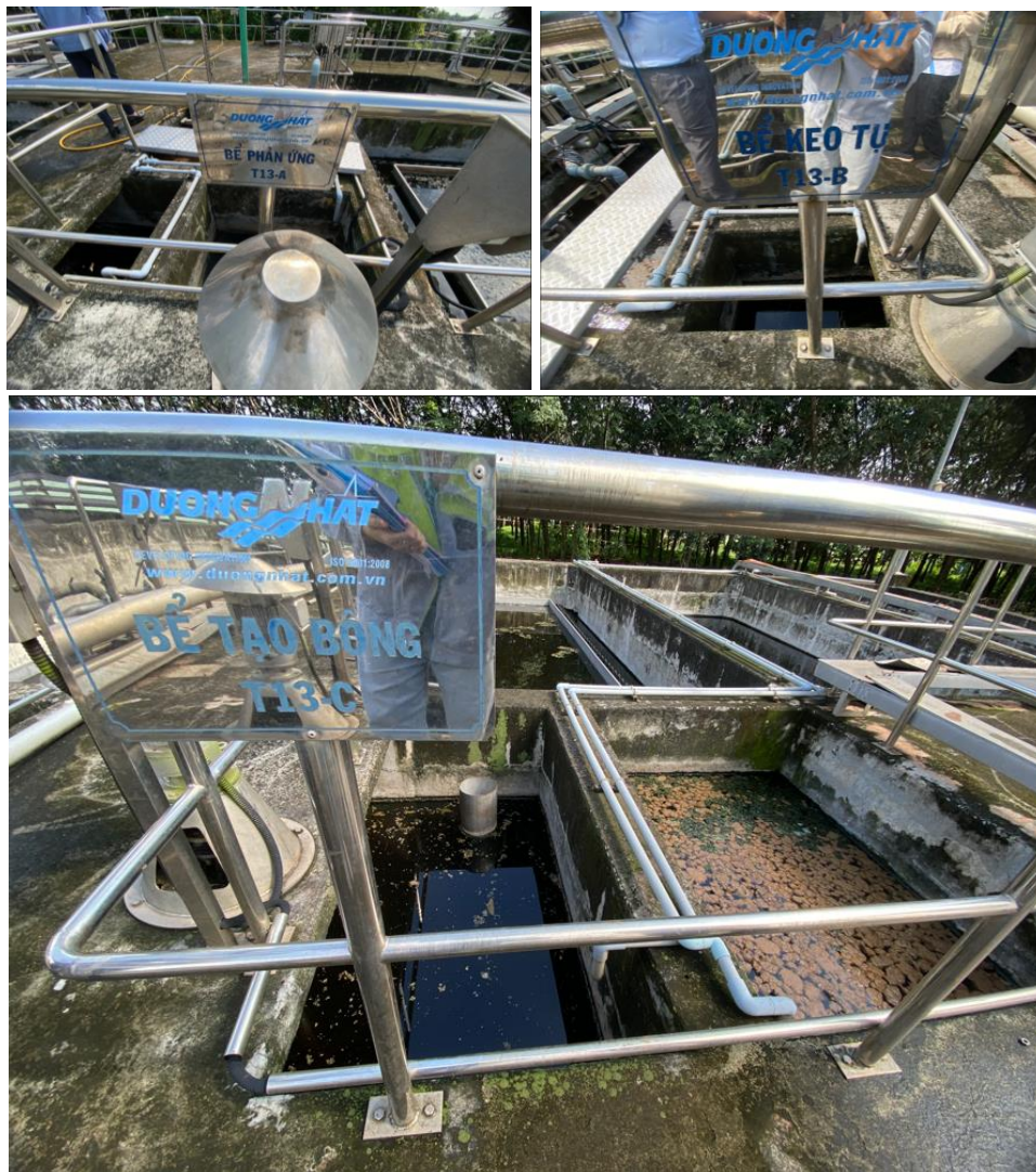
Hình 23: Bể keo tụ - tạo bông T13 (T13A, T13B, T13C)
