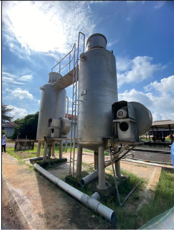
Hình 14: Tháp đuổi \text{NH}_3
