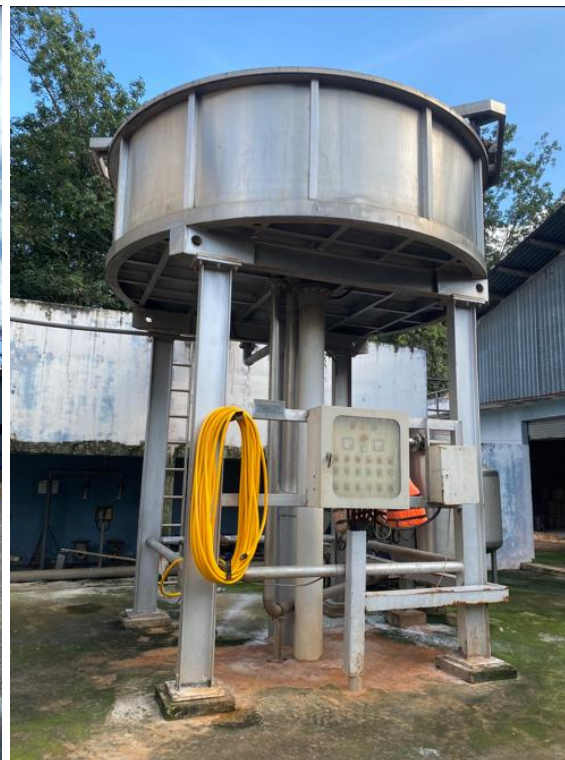
Hình 19: Tuyến nổi siêu nông DAF
