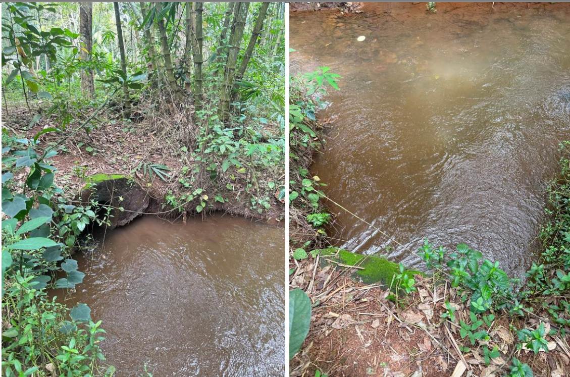
Hình 3. 8: Đường ống cống ngầm thoát nước vào suối Ao No
