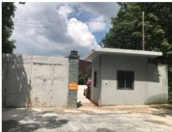
Hiện trạng công ra vào nhà máy tại khu I
