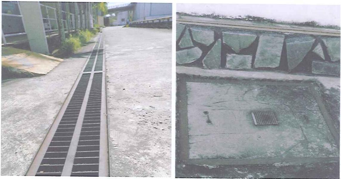
Hình 3.2 Hình ảnh hệ thống thu gom và thoát nước mưa
