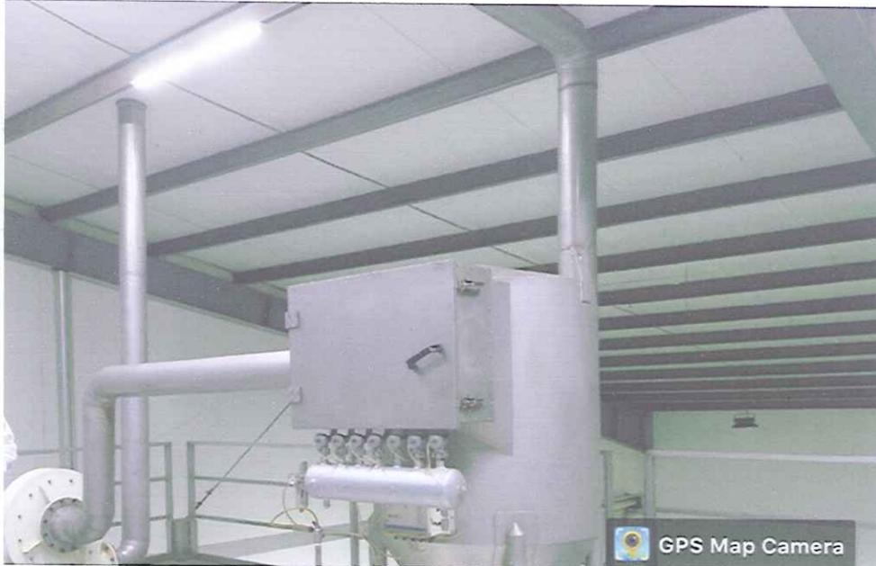
Hình 3.11 Hình ảnh hệ thống xử lý bụi khu vực đóng gói
