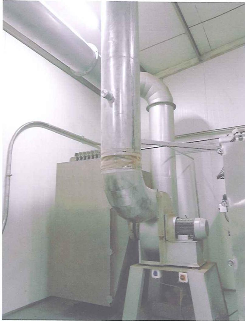
Hình 3.7 Hình ảnh hệ thống xử lý bụi từ quá trình sàng và tách đá, tách spiral
